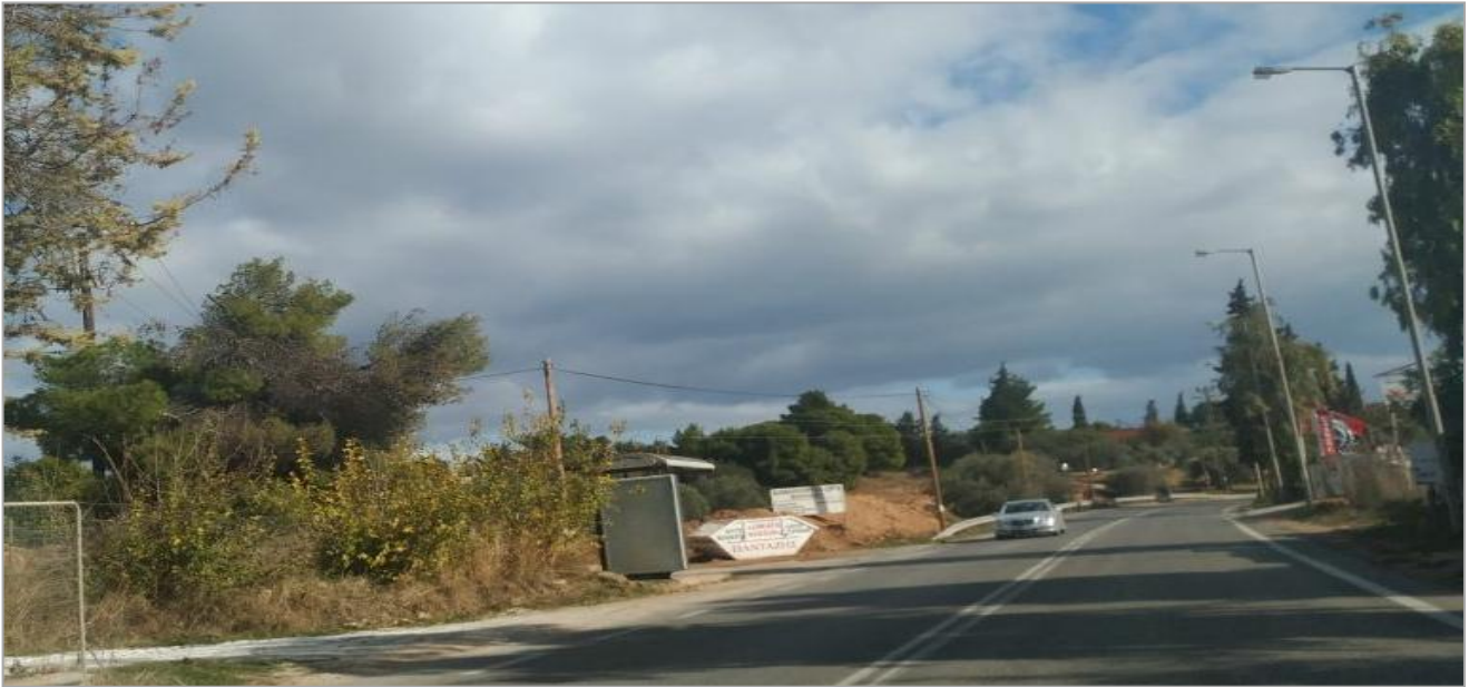
Εικόνα 3: Λεωφ.Φλέμιγγκ, πλησίον συμβολής με την οδό Μακεδονομάχων (Πηγή: αυτοψία αναδόχου)
