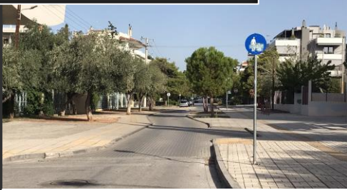
Πεζόδρομος με επίστρωση κυβόλιθου μπροστά από σχολείο στη Γλυφάδα, πηγή: Αρχείο αναδόχου
